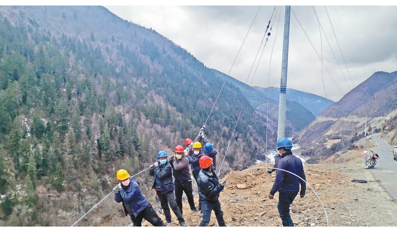
图为电力工人紧张施工，为边境县乡防疫检查站送去光明。 本报记者 袁海霞 摄
