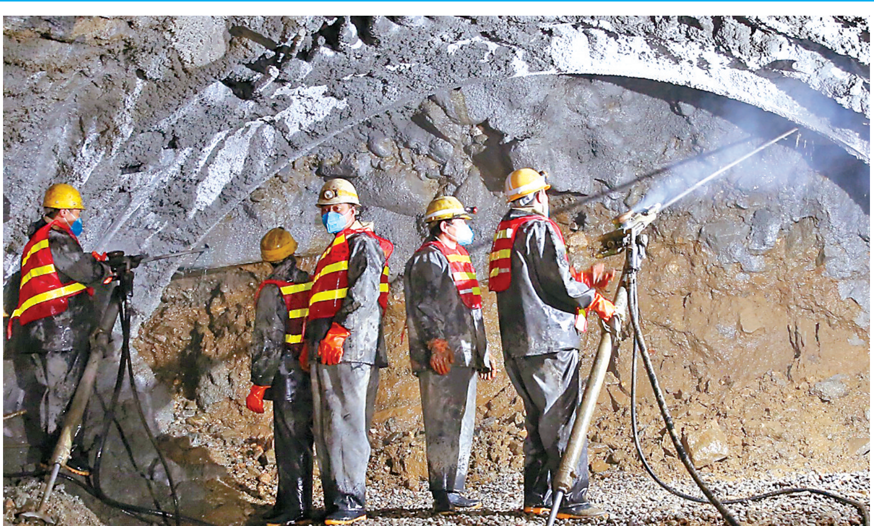
拉林铁路有序施工
