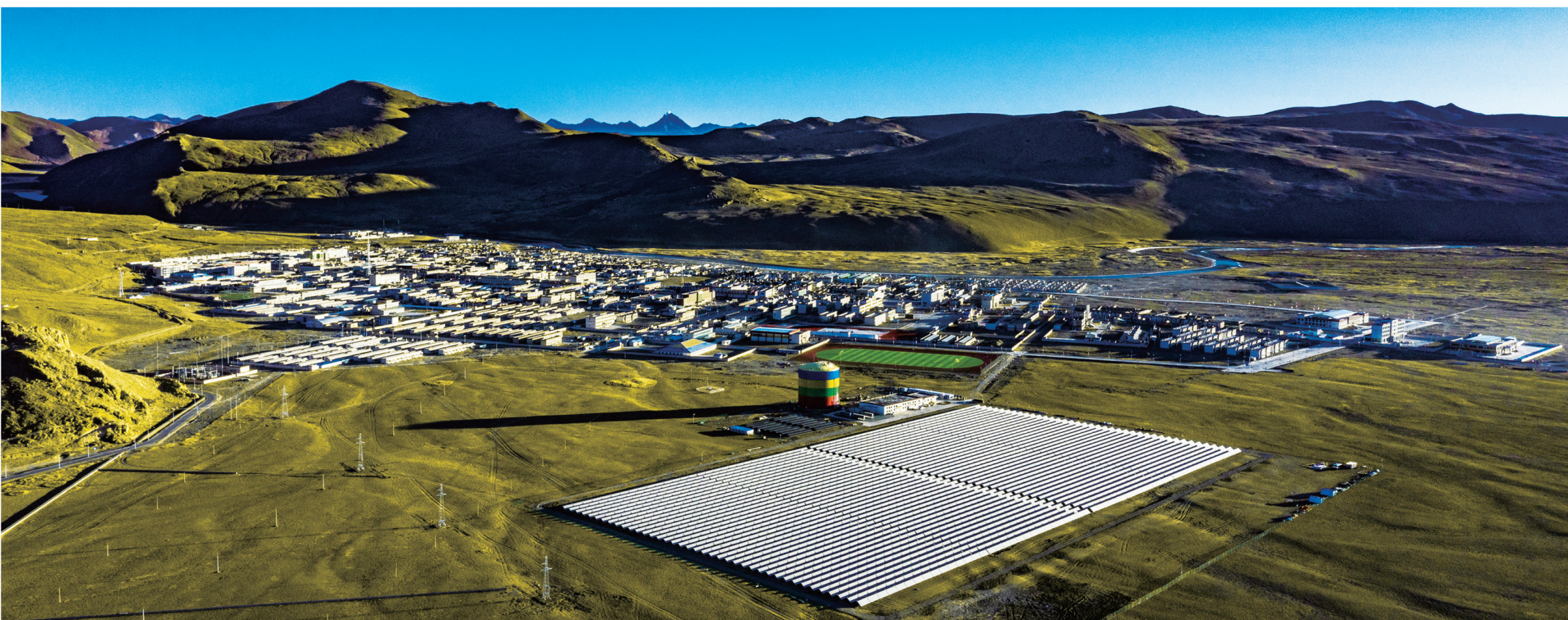
日喀则仲巴县城（2019年）世界海拔最高大型太阳能供暖项目 采暖建筑面积11万平方米
