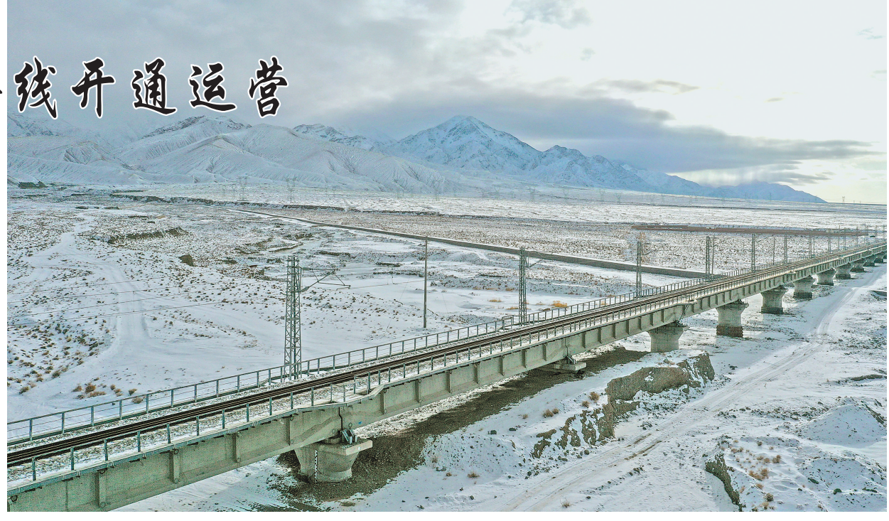
这是12月16日无人机拍摄的敦煌铁路大柴旦站附近的一处铁路桥。 新华社记者 张龙 摄
